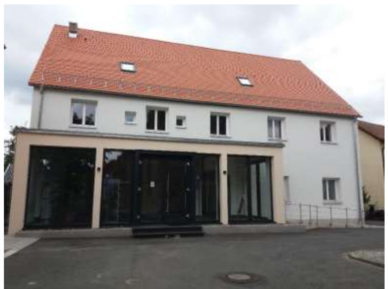
Das neu renovierte Gemeindehaus in Baiersdorf
